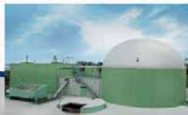
Realizzazione impianti chiavi in mano
