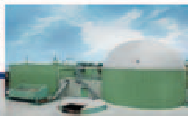
Realizzazione impianti chiavi in mano
