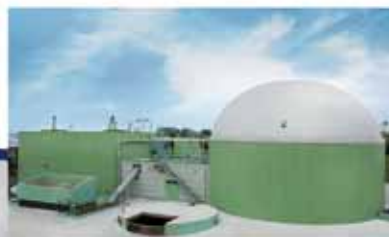
Realizzazione impianti chiavi in mano
