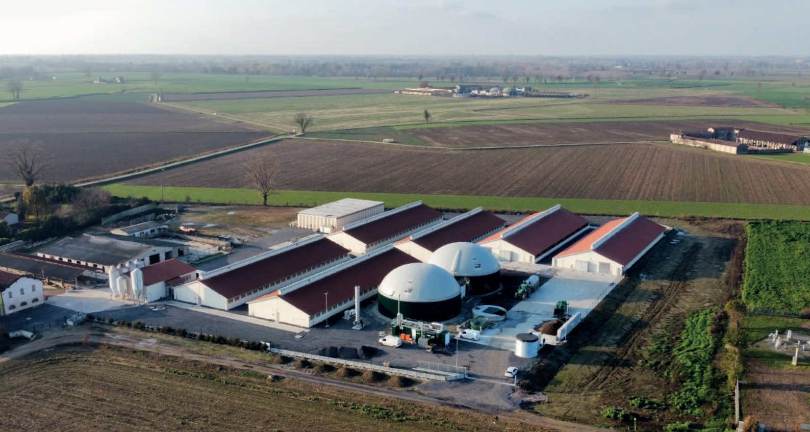
Formigara (CR) - Impianto Biogas 300 Kw
