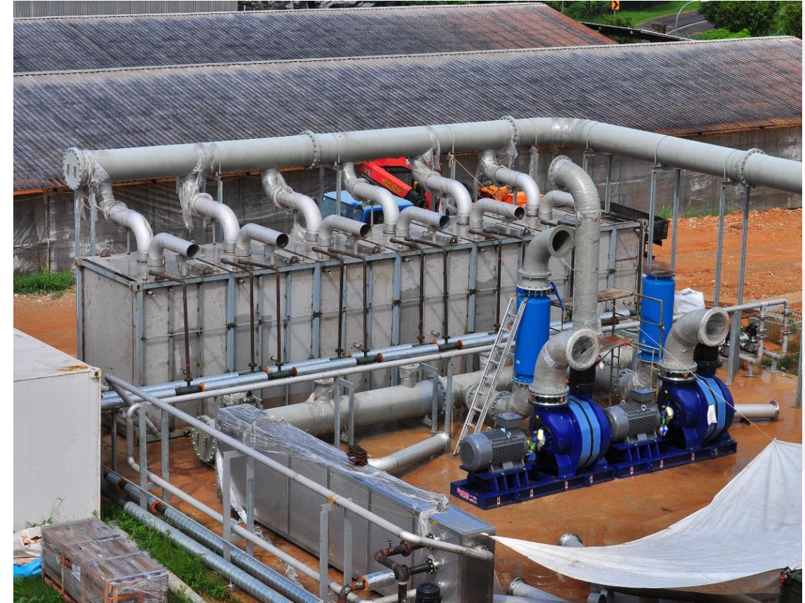
Sistema di strippaggio dell'ammoniaca
