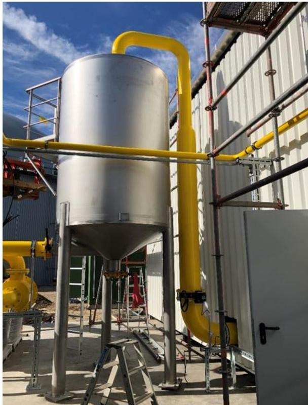
Sistema di filtri a carboni attivi, capacità 3000 – 6000 l, caricati con differenti tipologie di carboni per assorbimento  $\text{NH}_3$ ,  $\text{H}_2\text{S}$  e VOC
